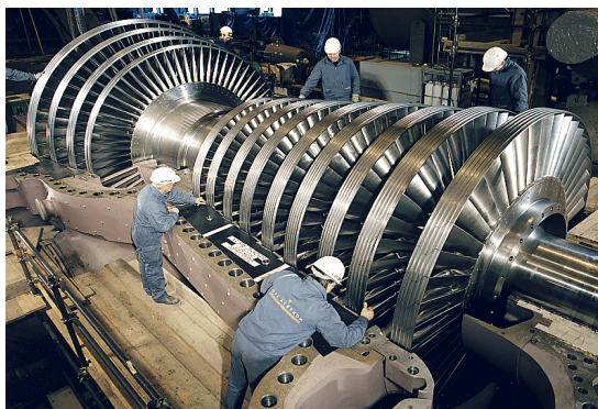
Turbine HPMP ARABELLE en montage à la centrale de Chooz B
