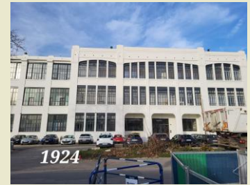
Façade de l'usine av Bataillon Carmagnole
